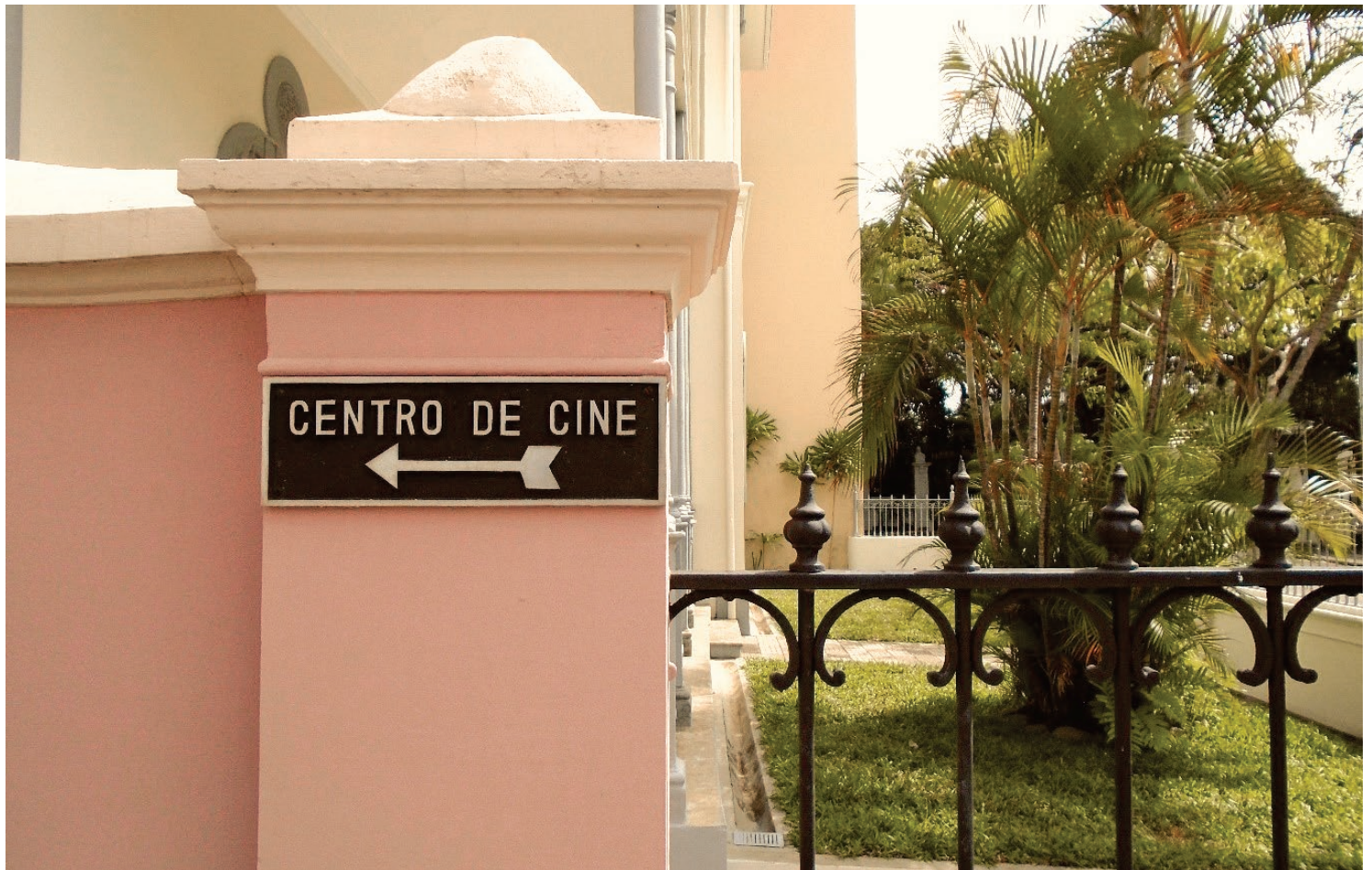
Figura 31 Colindancia norte, muro medianero y verja de hierro fundido.
